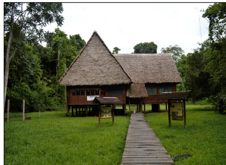
Figura N° 2: Imagen del estado actual del Puesto de Control de Limal, (enero-2019). Fotografía: Equipo de investigación. Fuente: Expediente técnico del Proyecto CIAL, PNM. Cusco - Perú (UAC, 2019).
