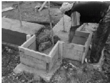
*Foto 03.- Instalación del encofrado de la cimentación*
