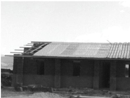
Foto 06.- Instalación de calamina en techo
