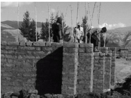
*Foto 04.- Levantado de muros de adobe*
