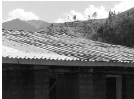
Foto 07.- Instalación de mangueras en techo
