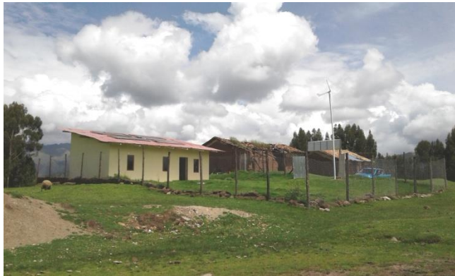
Foto 10.- Casa Solar Eólica terminada. (Foto: Vignes Electronics SAC)
