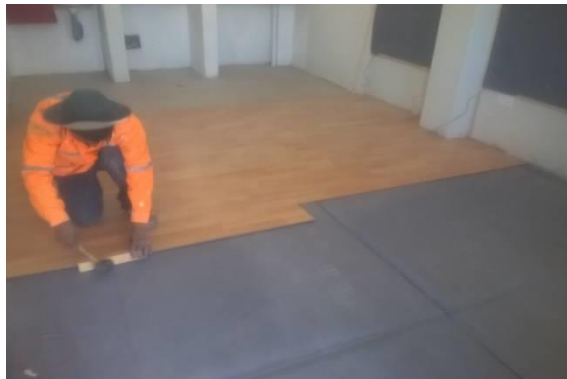
Foto 4.- Instalación de piso laminado encima de paneles térmicos
