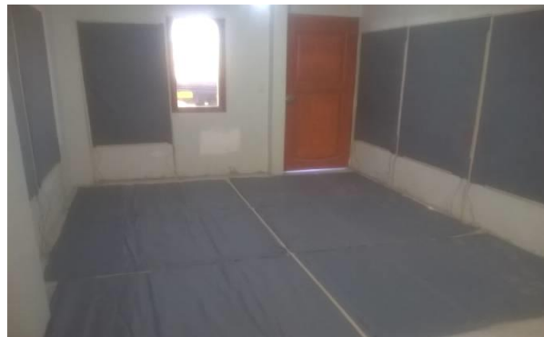
Foto 5.- Instalación de paneles térmicos en paredes y piso. (Foto: Vignes Electronics SAC)
