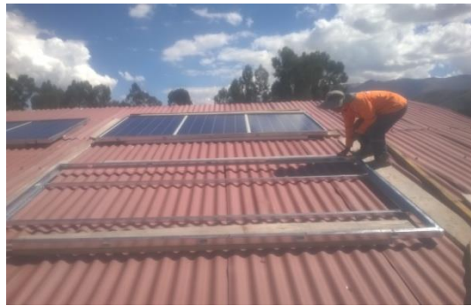
Foto 3.- Instalación de paneles solares fotovoltaicos en el techo
