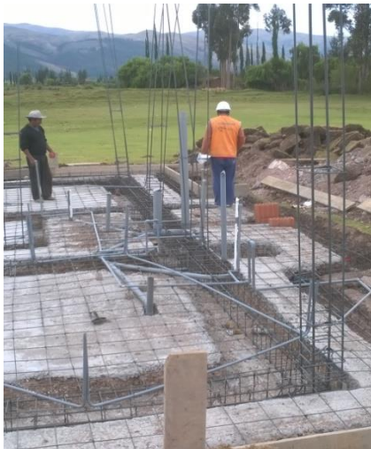
Foto 1.- Estructura antisísmica de vivienda
