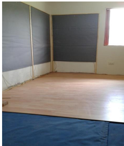
Foto 6.- Instalación de cobertura laminada en piso. (Foto: Vignes Electronics SAC).
